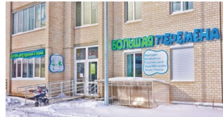
- объемные световые буквы на фасаде здания
