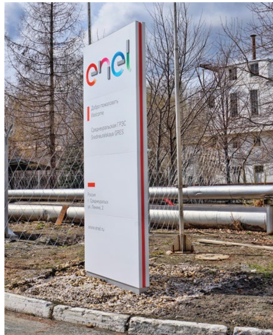
- стела из металлокаркаса на бетонном основании, обшитая алюминиевой композитной панелью
