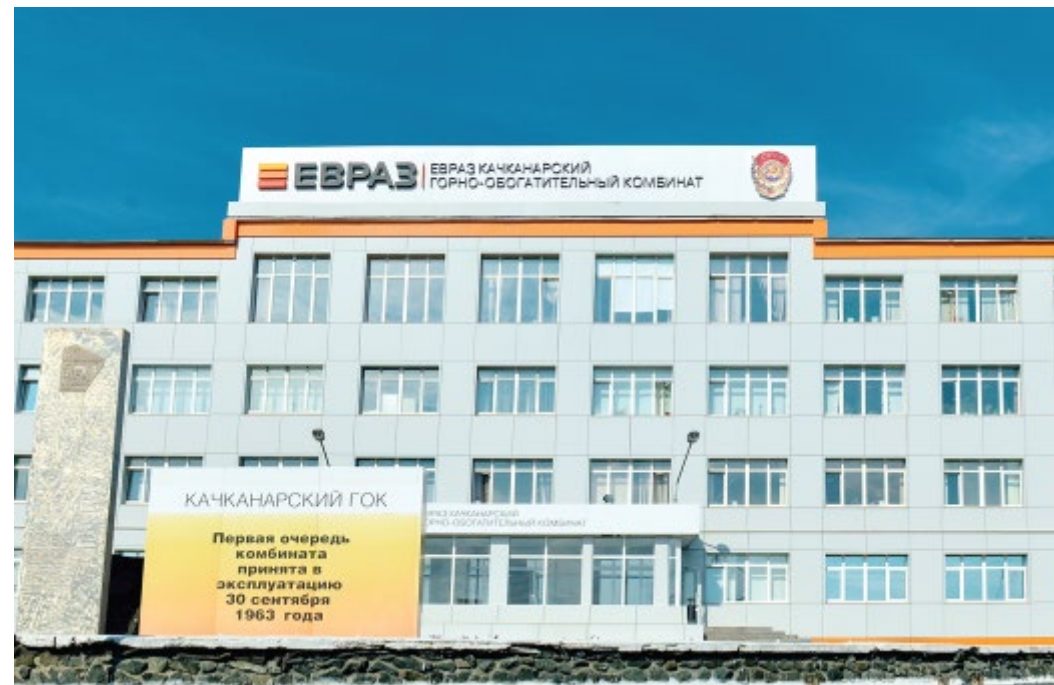
- объемные световые буквы на подложке из АКП на крыше здания
